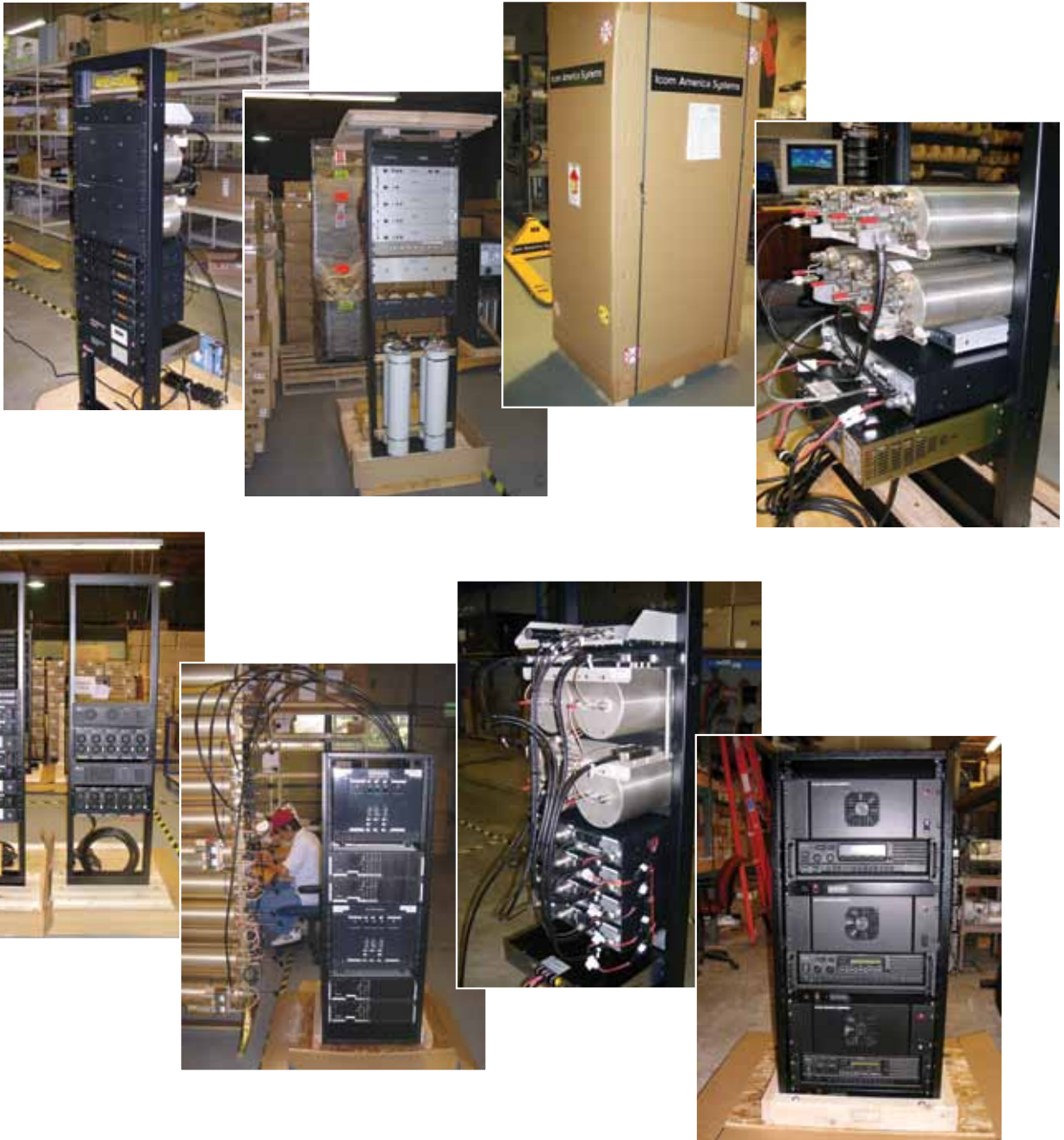
Fotografías de varios sistemas de radio en construcción en el área de ensamblado de IAS.
